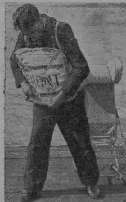
Nov rešilni pas za potnike v vodnih letalih. Rešilni pas je tudi podlaga za potniški sedež in je napolnjen z zrakom. V slučaju nesreče si ga lahko priveže potnik in se z njim obrzi na površju voda.
