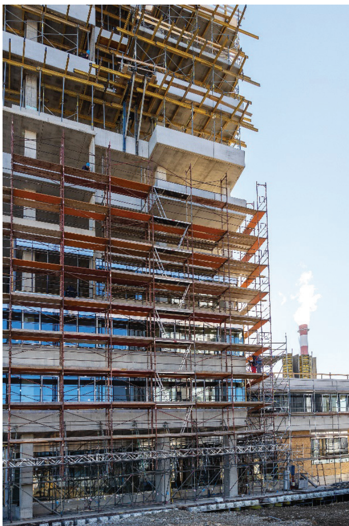
Slika 6. Prikaz razgibane armiranobetonske konstrukcije, februar 2022.
