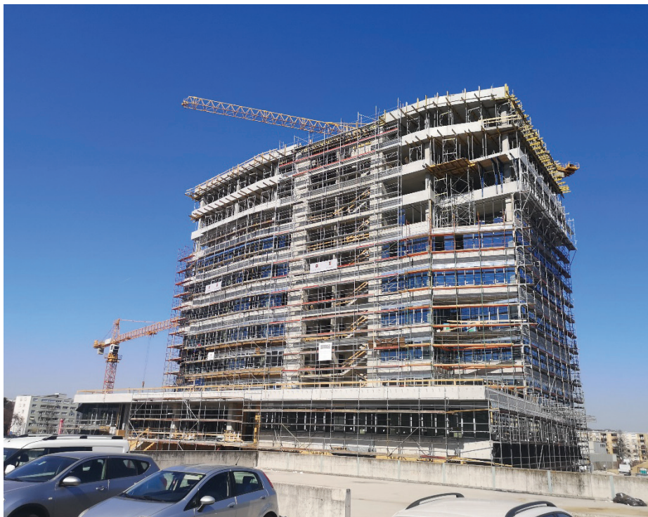
Slika 4. Izvedena streha nad 10. nadstropjem, april 2022.
