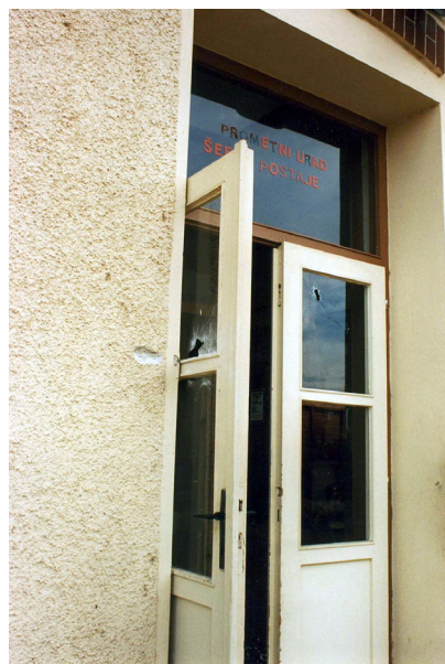
Slika 3: Železniška postaja Ormož – posledice strelav na vratih in fasadi z mostu na reki Dravi iz smeri Hrvaške (foto: Štefan Hozyan)
