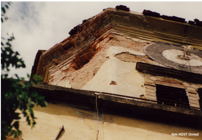
Slika 1: Poškodba stolpa ormoškega gradu, povzročena s tankovsko granato JLA (foto: Štefan Hozyan)
