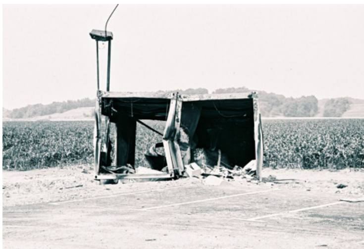
Slika 3: Fotografija z ogleda uničenih zabojnikov na mejni kontrolni točki Središče ob Dravi (foto: Bojan Orešek, OKS UNZ Maribor)
