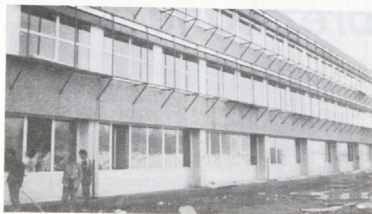
Informativno poslovni objekt »INA-OKI«. Objekt meri 3.000 m 2 , danes je na gradbišču še 30 delavcev, objekt je zgrajen, ureja se še zunanja ureditev. Vodja projekta Zlatko Botić, vodja gradbišča Stjepan Pinterić, delovodja Mato Štaba.
