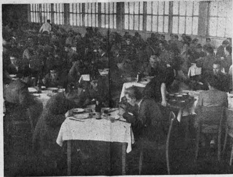
Jedilna dvorana za delavce v Litostrój
