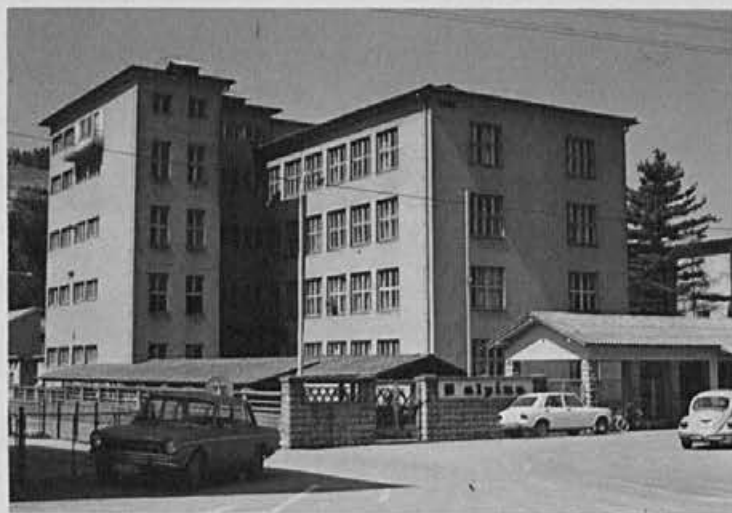
Stara stavba Alpine sedaj predstavlja že manjši del celotne tovarne
