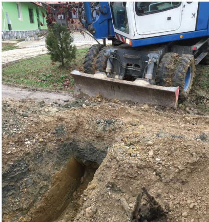
Položeni cevovodi za električno omrežje
