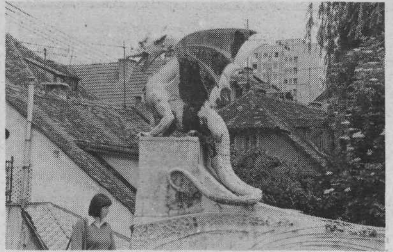
Zmajski most ni samo »zmajski«. Gre za pomembno prometno žilo, ki povezuje severni del mesta z južnim. Prek mostu poteka vsaj za zdaj tudi težki tovorni promet. Zaradi tega je nadvse pomembno, da je most trden in da ima ustrezno nosilnost.
