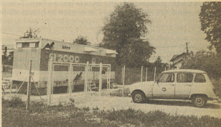
Kontejner je gospodarna in učinkovita rešitev za namestitev telefonske centrale.
