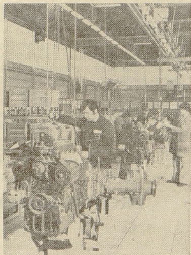
Začetna faza montaže traktorja na montažnem traku
