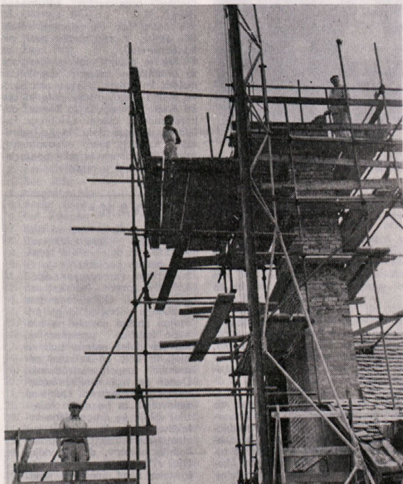
Naprava dimnika centralne kurjave na centralnih obratih. Delo remontne skupine obrata.
