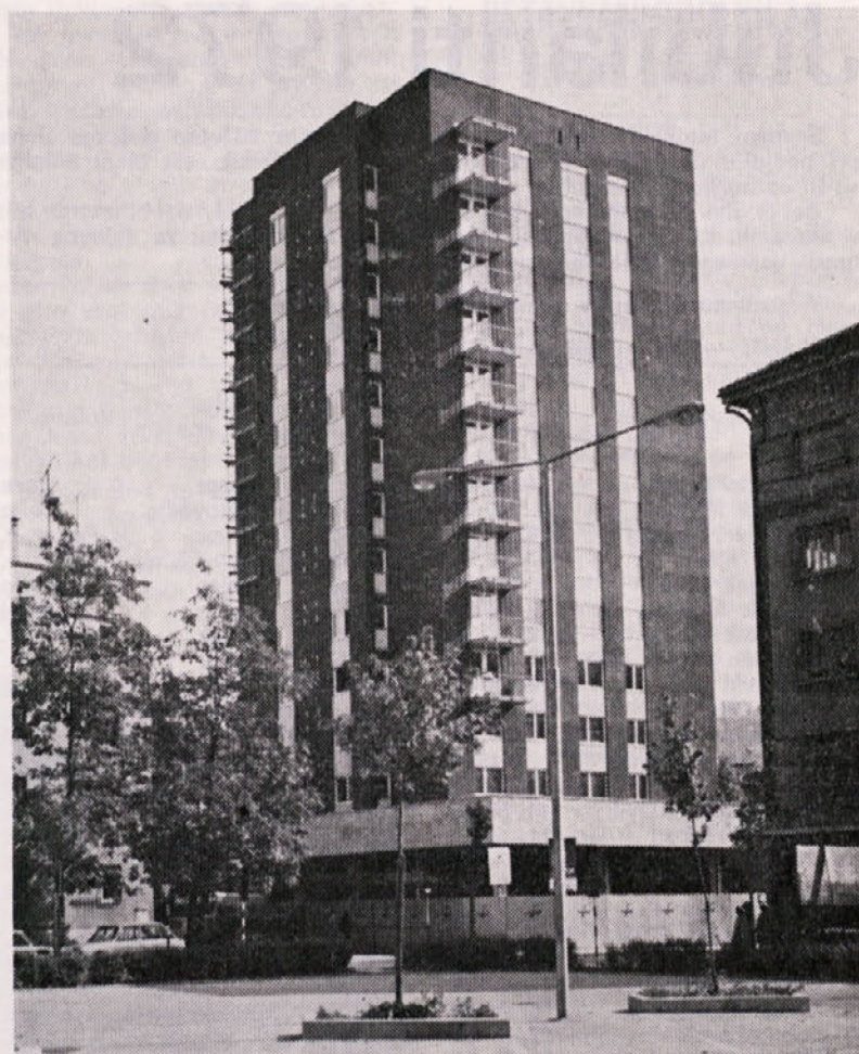
Stanovanjska stolpnica v centru mesta je končno v zaključni fazi.
