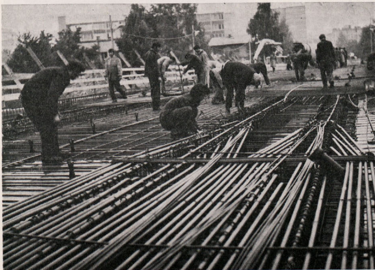
Železokrivci so hiteli z vezanjem armature proti desnemu bregu, medtem ko so z levega brega že pričeli z betoniranjem.
