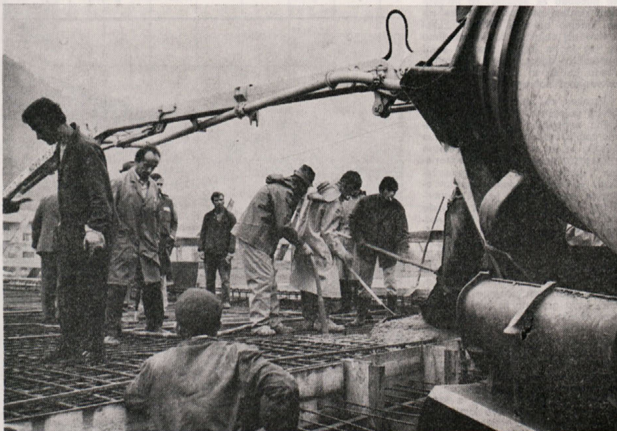
Most Čopova — mehanizacija deluje, betoniranje se je pričelo.
