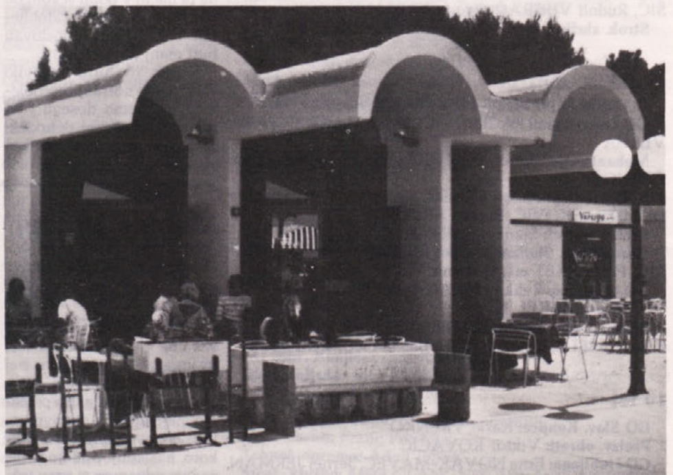
V Novalji na otoku Pagu so delavci GO Ljubljana zgradili zanimiv turistični objekt.
