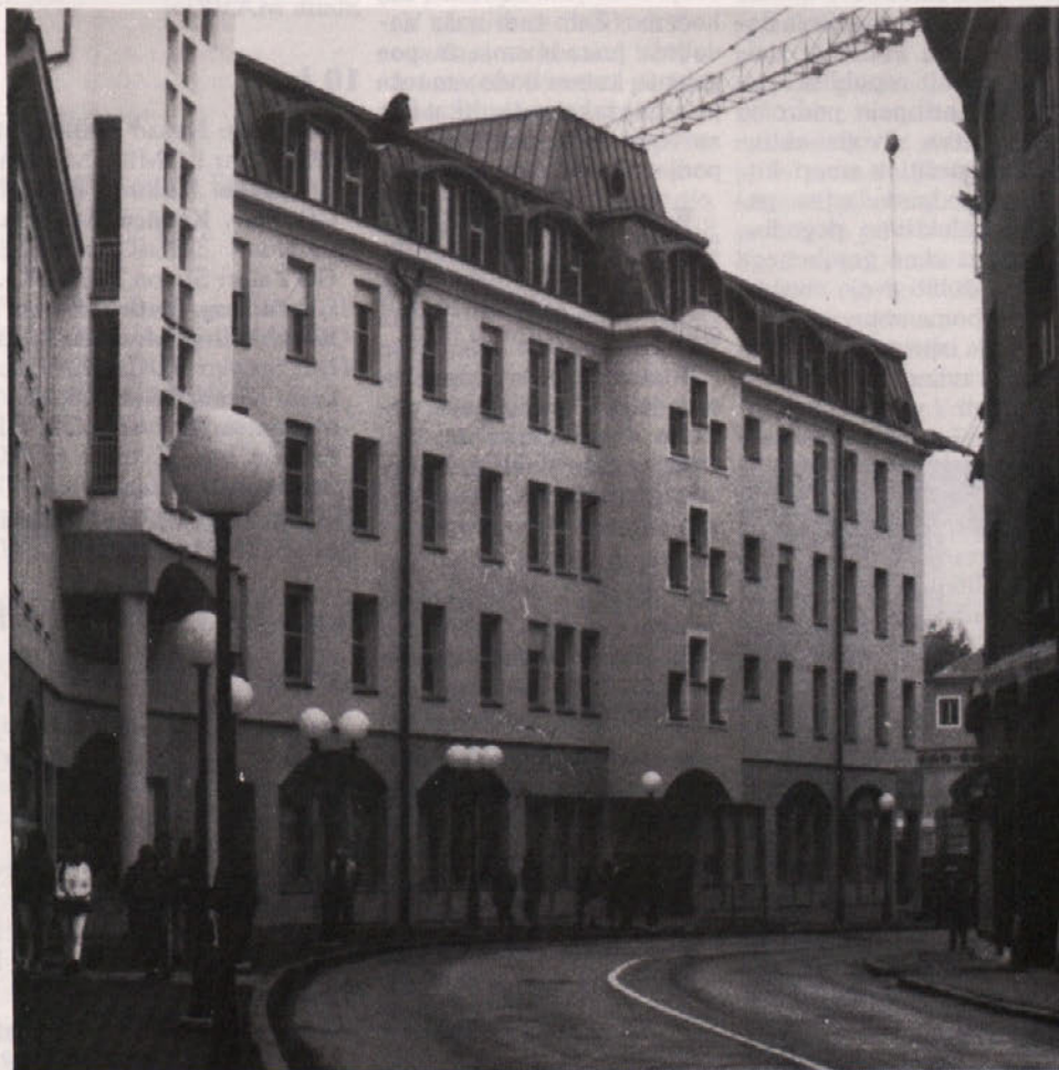
Prejšnji mesec se je celjska SDK preselila v nove poslovne prostore. Objekt sta zgradili podjetji Ingrad in Gradis, a še ni zaključen in se bo gradnja nadaljevala. Sodobno zasnovana arhitektura se lepo sklada z bližnjimi stavbami. Foto Vili Šuster.
