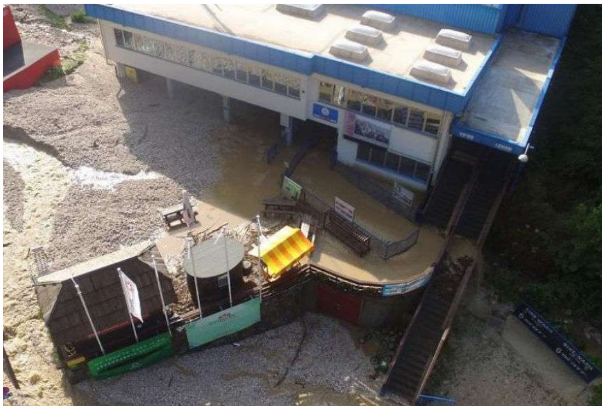
Slika 4. 30. maja zvečer se je ponovil dogodek iz leta 1991, ko je hudournik Reka s svojim nanosom v obliki drobirskega toka zasul spodnjo postajo kabinske žičnice na Krvavcu. V 40 minutah je bilo na Krvavcu izmerjenih 51 milimetrov padavin (Vir: ARSO, foto: PGD Cerklje)
