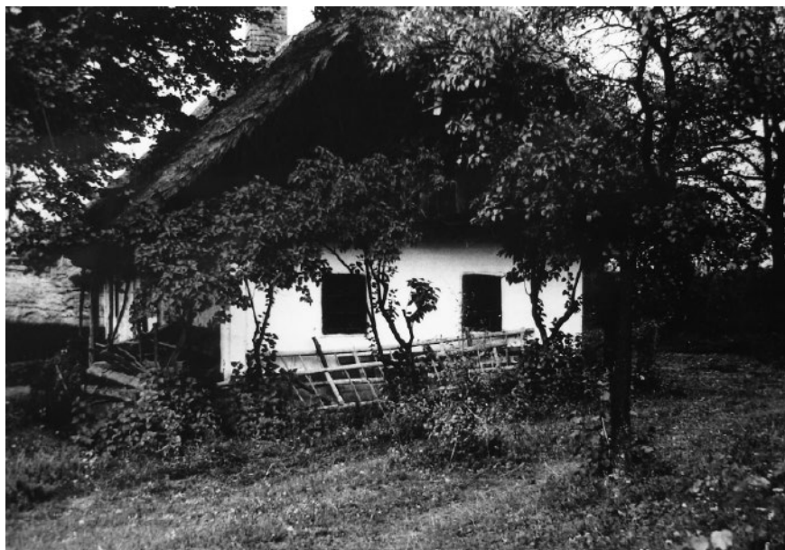
Slika 1: Rojstna hiša Marije Prijol na Stari cesti pri Cezanjevcih (zasebni arhiv Andreja Požarnika)
