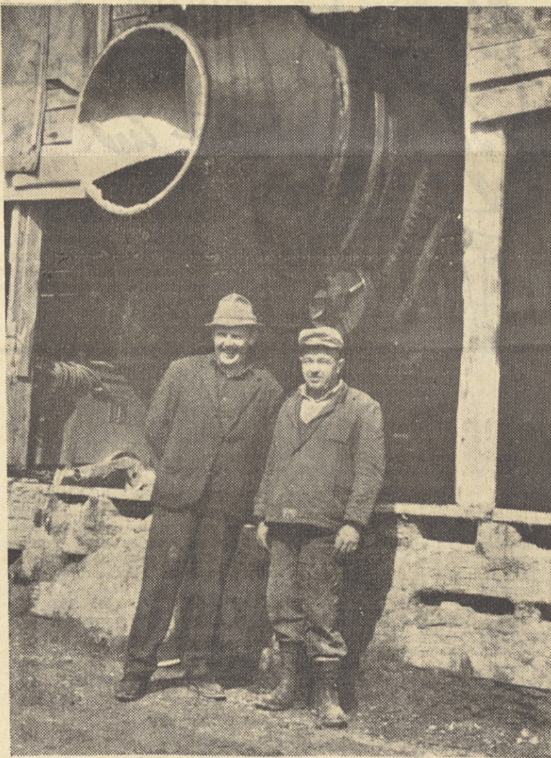
Delovodja Milan Majžir in strokovnjak Janez Čerman sta v letošnjem letu zmešala za potrebe kapitalne izgradnje železarne Ravne na Koroškem nad 4000 m 3 kvalitetnega vodotesnega betona
