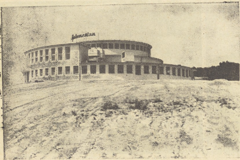
Popravljamo napako! Tole je vinska klet v Ljutomeru. Objekt je razdeljen na 4 etaže, v katerih so razporejeni sodi. Vsaka od etaž ima 18 sodov po 1250 litrov, 69 sodov po 3000 litrov, 52 sodov po 5000 litrov in 20 sodov po 6500 litrov
