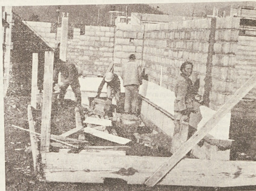
Zidovi posebne šole v Slovenj Gradcu bodo obloženi z lepo fasadno opeko
