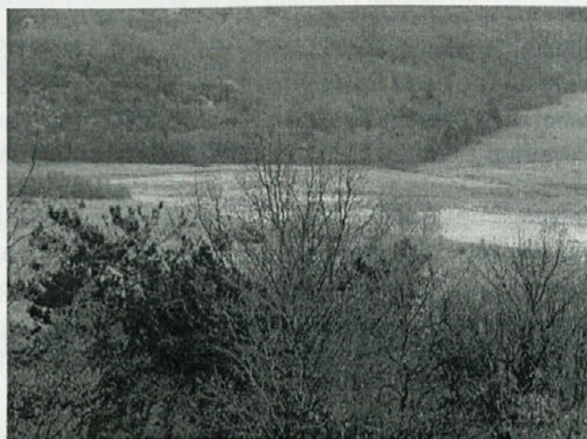
Razgaljena tla – gradbišče strelišča na Mlakah
