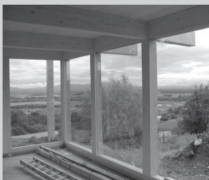
□ Slika 6. Skeletna gradnja omogoča veliko steklenih površin
