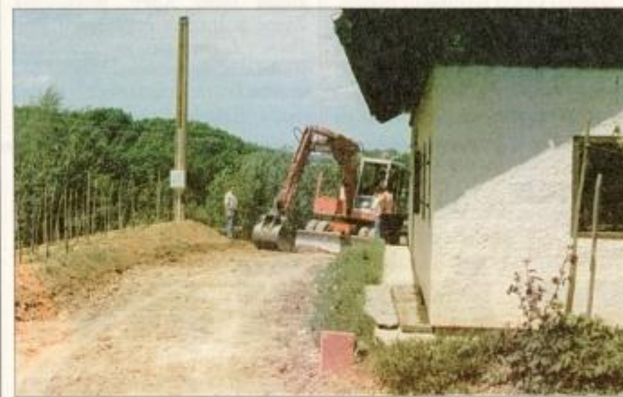
Na cesti v Paradižu potekajo obsežna zemeljska dela.
