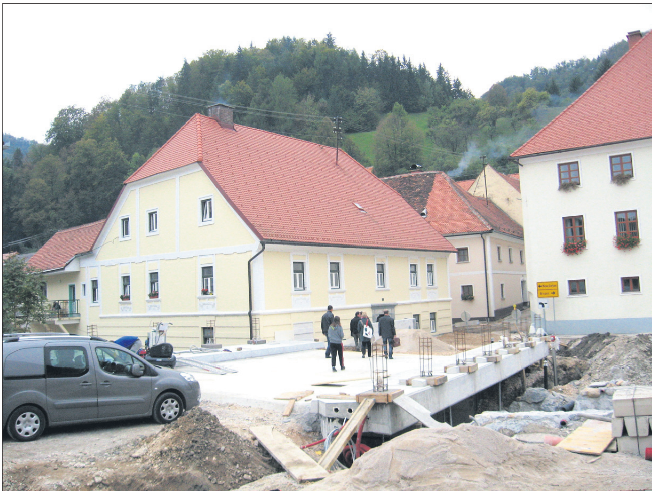
Gradbišče novega Pirhovega mostu v središču Vitanja na državni cesti, ki vodi skozi trg. Bodo dela ustavili, se je država res znašla v tako hudem finančnem položaju?
