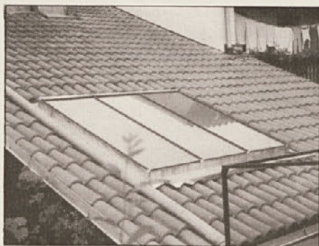
Kolektorji na strehi po končanem delu.
