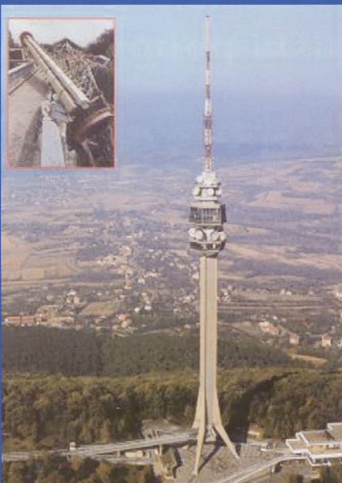
Stolp pred in po rušenju
