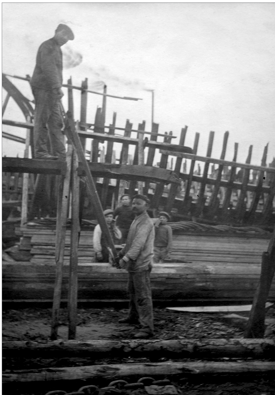
Izdelovanje lesenih plovil v piranski ladjedelnici. Žaganje lesa in gradnja ladijskih reber.
