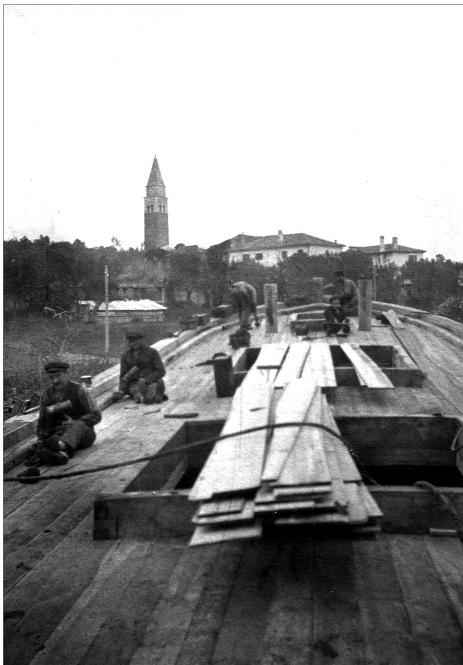
Izdelovanje lesenih plovil v piranski ladjedelnici. Kalafatanje oplate in palube.
