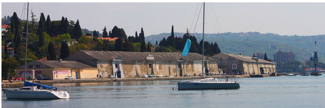
Skladišči soli Monfort in Grando (Wkimedia Commons).
