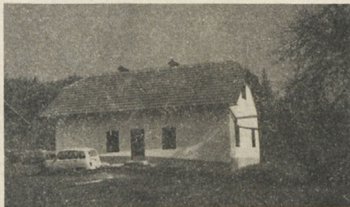
Na našem območju imamo precej stavb, ki so včasih služile kot logarnice ali kot delavska zavetišča. Časi pa se spreminjajo. Na delo se vozimo vsak dan in večina stavb sameva. Z občasnim načenjanjem, mi pa, kot dobri gospodarji, jih moramo vzdrževati. Na fotografiji je stara gozdarska hiša na Podstencih, ki smo jo letos obnovili. (Foto: B. Miklič)
