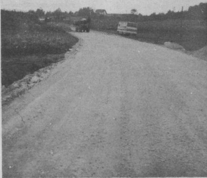
Del ceste proti Vilični vasi bo kmalu asfaltiran
