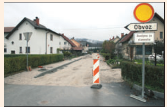
Na delu Lošče bodo še letos dobili nov plinovod, vzporedno pa naj bi obnovili tudi druge komunalne vode.
