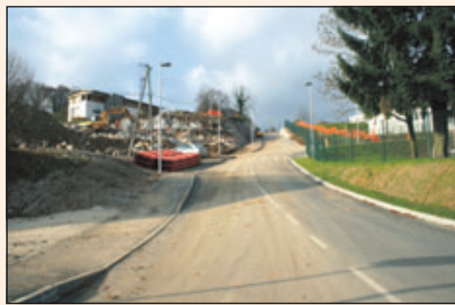
Nova cesta čez Košace, ki je bila prvenstveno zgrajena za novi vrtec, obenem pa služi tudi za razbremenitev prometa čez Košace in kot navezovalna cesta za tamkaj novo nastajajočo sosesko.
