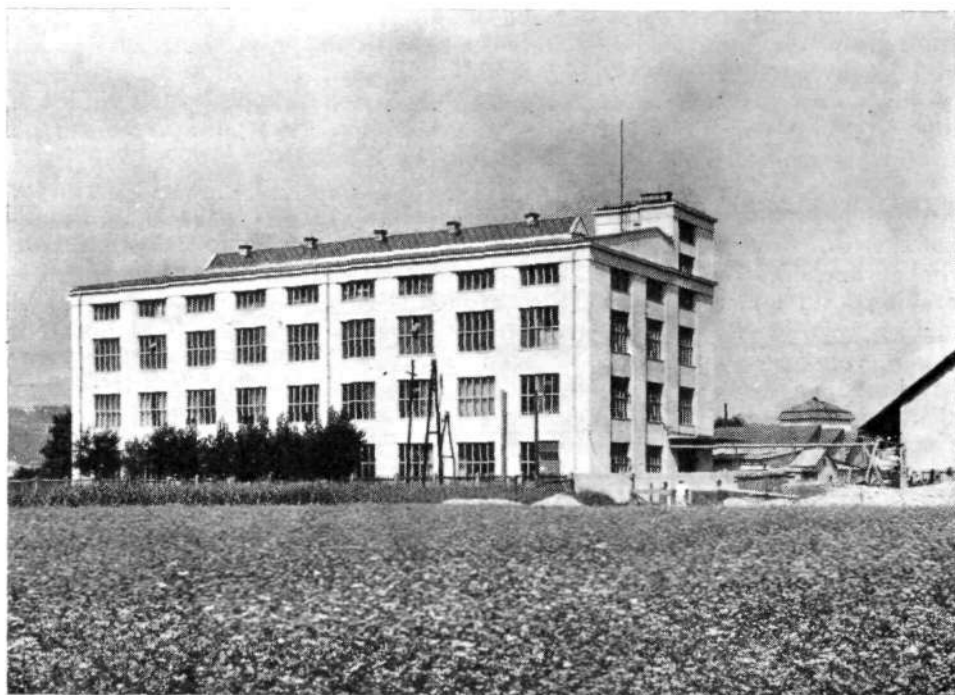
Stavba predilnice za vigogne prejo. (Foto Exportprojekt)
