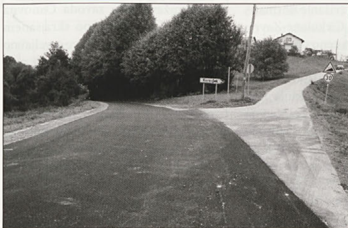
Od poletja moderniziran odsek ceste v Brezovcu, ki se navezuje na občino Zavrč.
