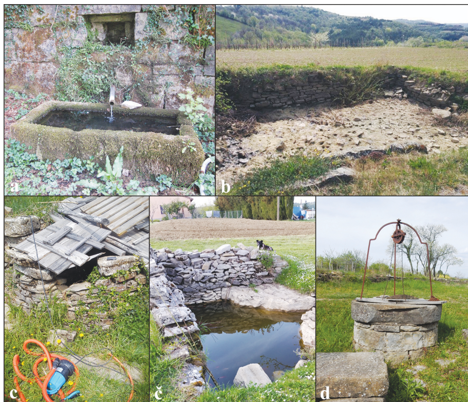
Slika 3. Kategorije zgrajenih objektov za zbiranje (zajem) in hranjenje vode ((a) – izvir z rezervoarjem in izlivom, (b) – obzidan kal, (c) – pokrit vodnjak, (č) – odprt vodnjak, (d) – visoko obzidan vodnjak) (fotografije: Valentina Brečko Grubar).
