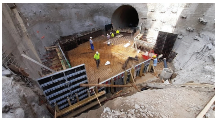
Slika 8. Temeljna plošča novega odzemnega objekta.
