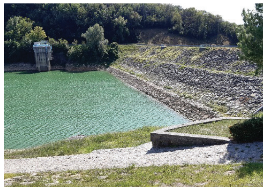
Slika 3. Vodna stran pred posegom.
