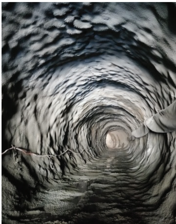
Slika 23. Gradnja predora – primarna podgradnja.
