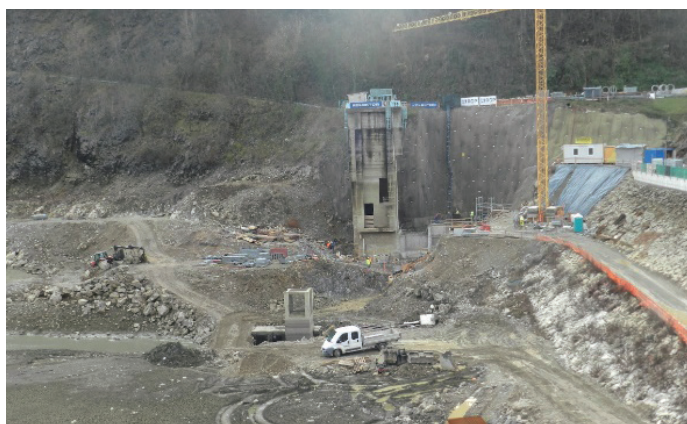
Slika 17. Začetek gradnje dovodnega jarka.
