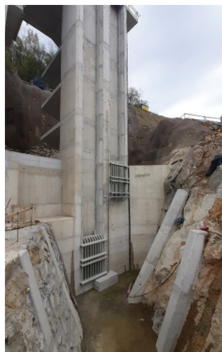
Slika 14. Novi odzemni objekt – po izvedbi vtočnega jarka.
