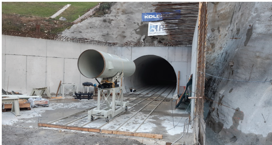
Slika 26. Transport cevi v predor za montažo.
