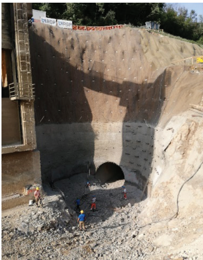
Slika 7. Gradbena jama – spoj s predorom.
