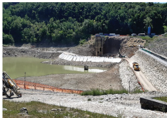
Slika 4. Dostopni cesti in zaščitni nasip gradbene jame za gradbeno jamo za odvzemni objekt.
