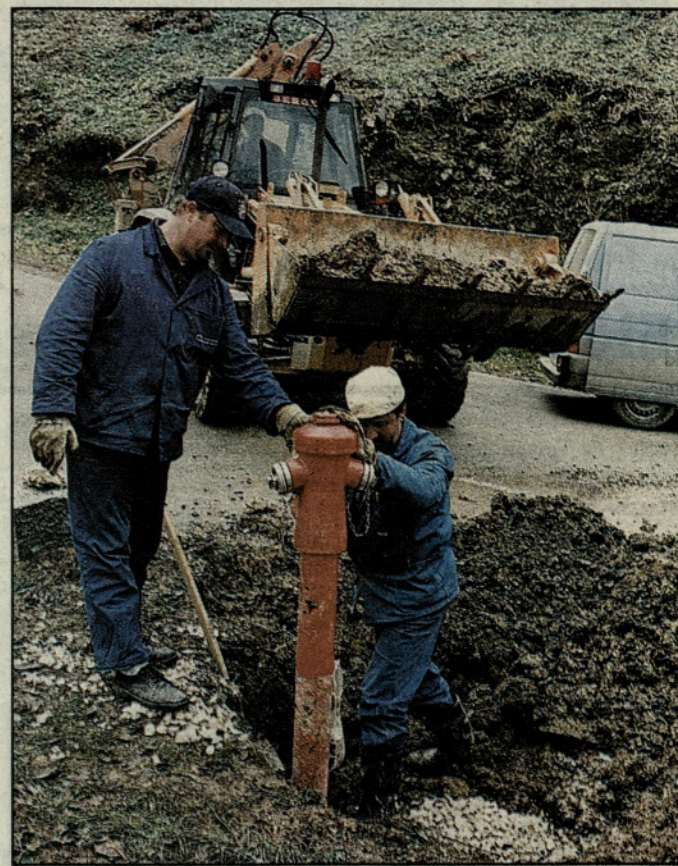
Pri postavljanju nadzemnega hidranta v Letušu
