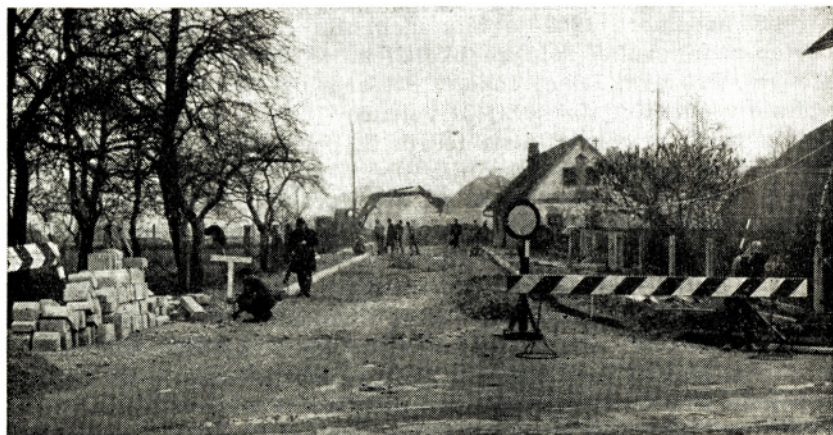
Modernizacija ceste Mengeš—Rodice 1968
