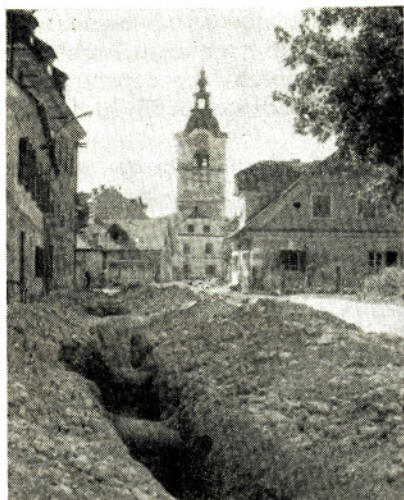
Gradnja vodovoda v Mengšu 1963
