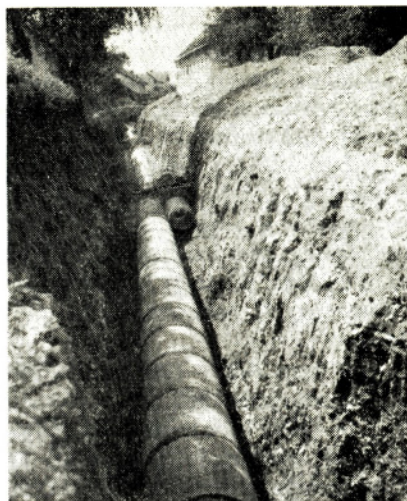
Gradnja kanalizacije po Tomšičevi cesti v Mengšu 1967
