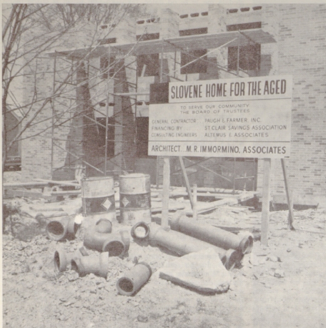
Gradbišče novega prizidka Slovenskega doma za ostarele v Clevelandu. Foto: Jo Mišič
