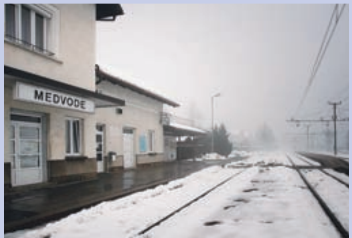
Na Železniški postaji Medvode je bila zamenjana streha in stavbno pohištvo, za prihodnje leto je predvidena še obnova fasade. / Foto: Matic Zorman
