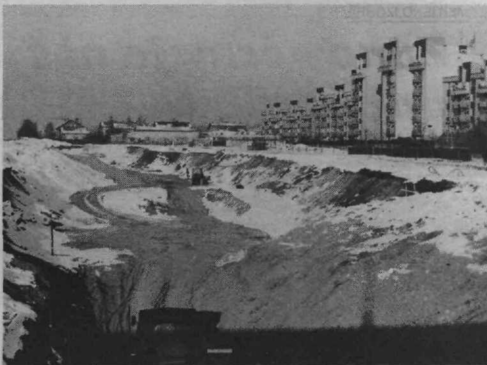
NA NAJVEČJEM GRADBISČU ZA BEŽIGRADOM
