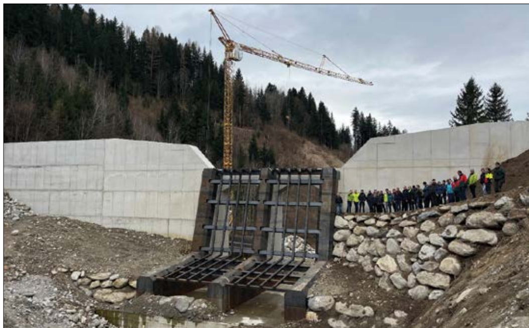
Slika 1: Gradnja velike hudourniške lovilne prebiralne pregrade na hudourniku Kaningerbach v Avstriji (foto: M. Kobal)
