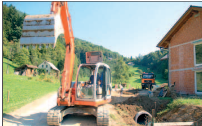
Obnovitvena dela ceste Pod hribom v Horjulu
