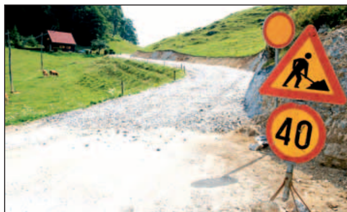
Obnovljeni del ceste Seč-Prevaljca je že pripravljen za asfaltiranje.
