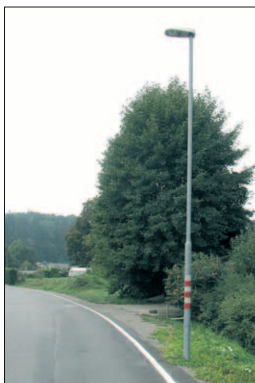
Obstoječo javno razsvetljavo bodo obnovili.
