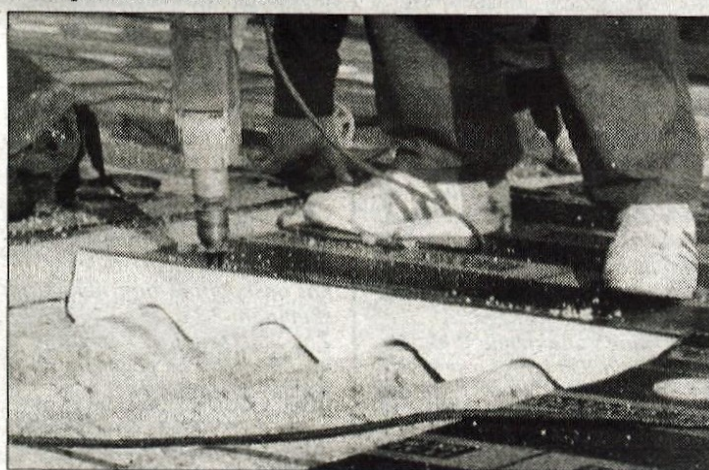
Po obnovi strehe s termovalom azbest ne onesnažuje več okolja.
