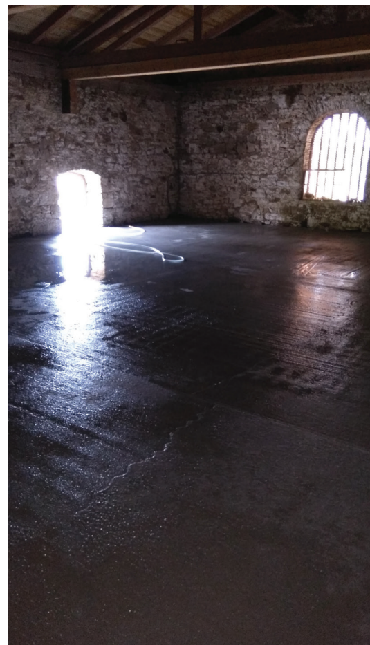
Z novo betonsko ploščo je dvorana v Gradu izolirana.
