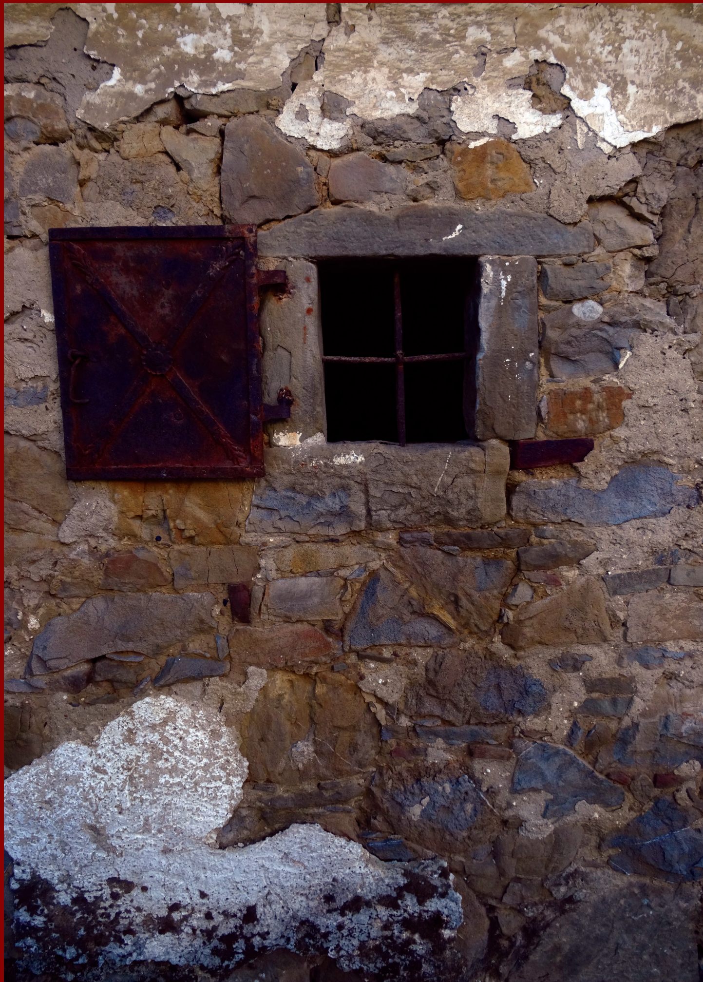
Okno s železnim polknom na Mihotově hiši
