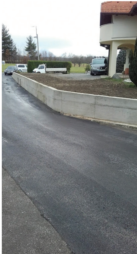
Urejena cesta pri Brgujcu na Zemonški vagi
