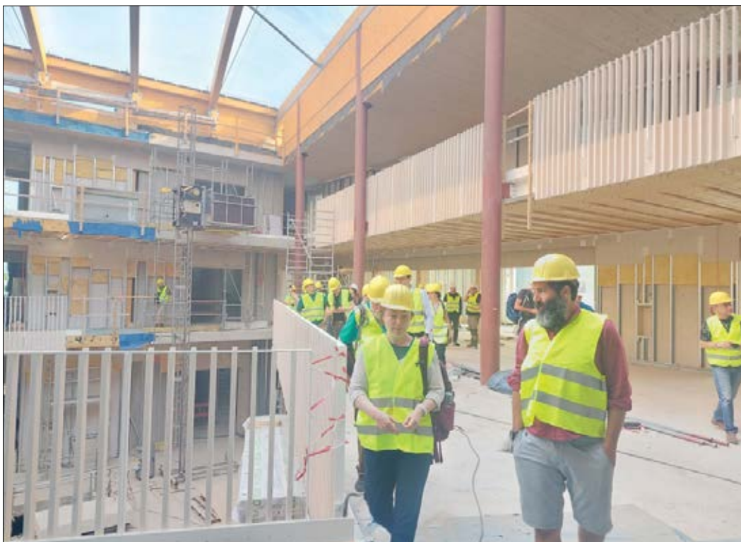
Slika 5: Ogljed gradnje šole in vrtca (foto: K. Sever)
