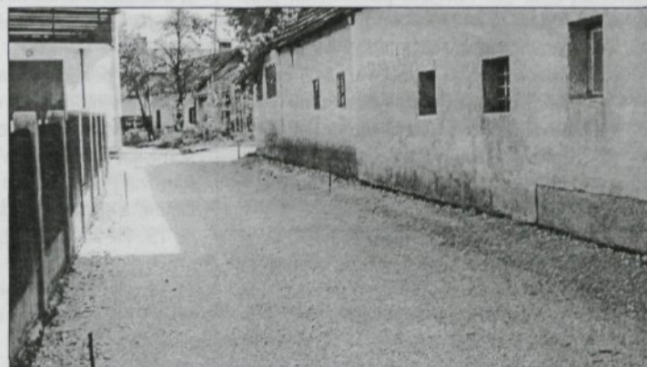
CESTA V LOKI PRED ASFALTIRANJEM
