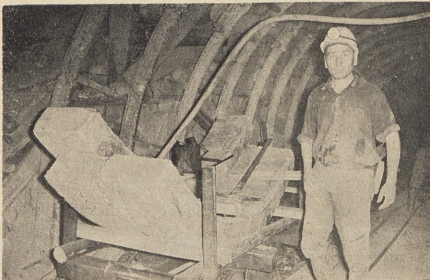
Jože Valentinčič je sodeloval pri montaži panelnih blokov v jami rudnika Trbovlje. Foto inž. Tone Bregant
