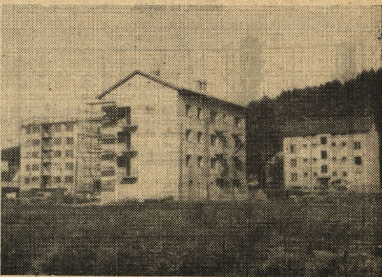
Stanovanjski blok, ki ga gradi Železarna v Šentjurju
