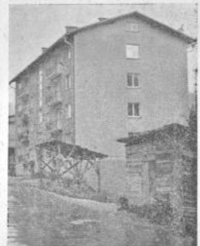
Stanovanjski blok, ki sta ga zgradili laški podjetji »Pivovarna« in »Volna«.
