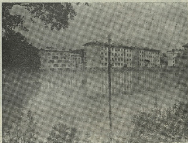
Poplavljeni novo zgrajeni bloki
