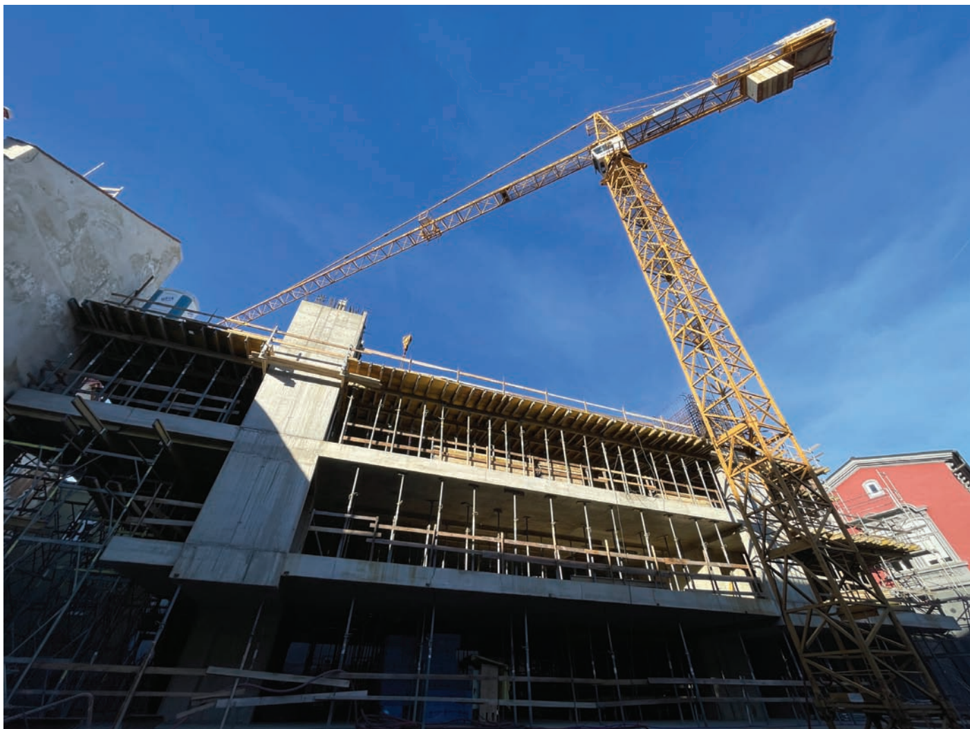
Slika 2. Gradbena dela na novi Mariborski knjižnici (25. 11. 2024).
