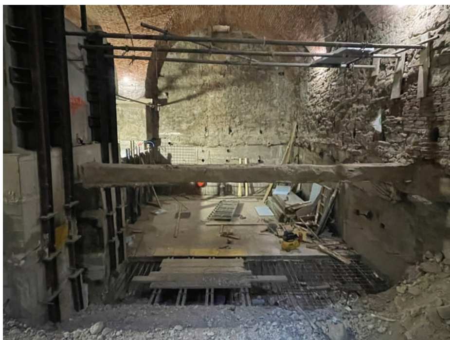
Slika 6. Pogled na gradnjo Art Kina Rotovž (25. 11. 2024).
