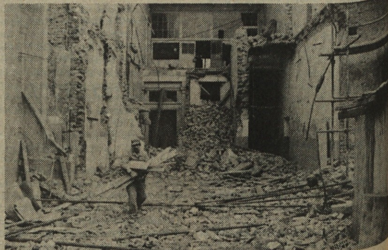
Kljub mehanizaciji je potrebno veliko del opraviti ročno
