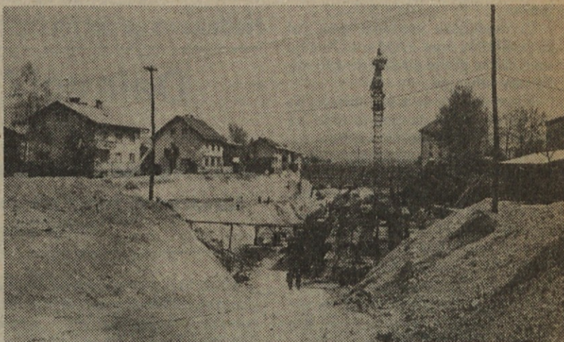
Referenčni Gradisov objekt
