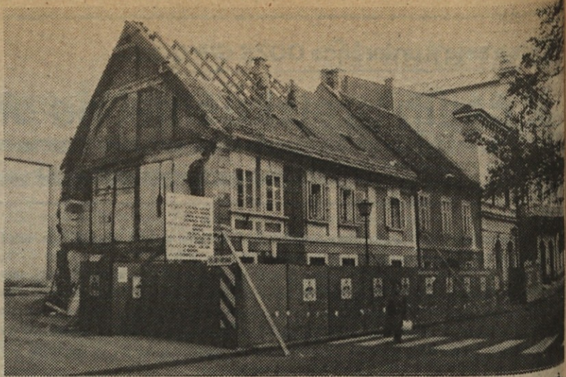
Zaradi izgradnje nove dvorane SNG so morali porušiti tudi ti dve stanovanjski hiši. V ozadju levo vidimo odprtino bodočega novega odra. Foto: F. S.
