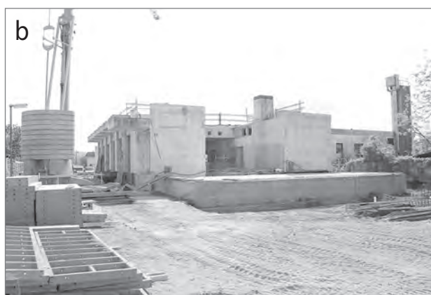
Slika 6: Še maja leta 2016 so bili načrti, vezani na prenovo Družbene prehrane v Murski soboti, nejasni (a), marca 2017 pa so se že začela gradbena dela na objektu (b) (foto: Tatjana Kikec).
