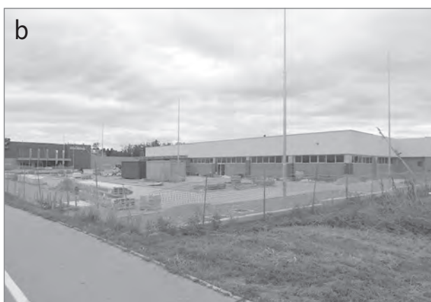
Slika 7: Opuščeno gradbišče načrtovane izgradnje trgovine Tuš v vzhodnem delu Kranja je dolga leta samevalo (a), leta 2017 pa je ponovno oživel. Na približno tretjini površine območja se izvajajo gradbena dela (gradnja trgovine Eurospin) (b) (foto: Luka Verlič).
