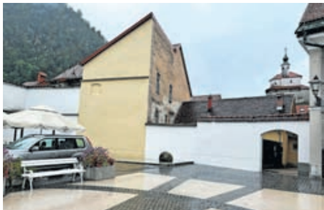
Obnovljen zid med Plečnikovo stavbo in Maleševо galerijo
